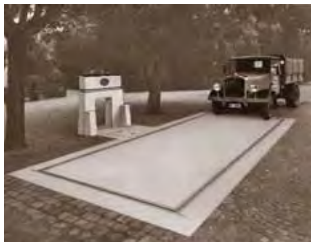
Brückenwaage 10 x 3 m
