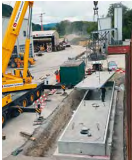
Montage einer Einbau-Fertigteil-Fahrzeugwaage 20 x 3 m
