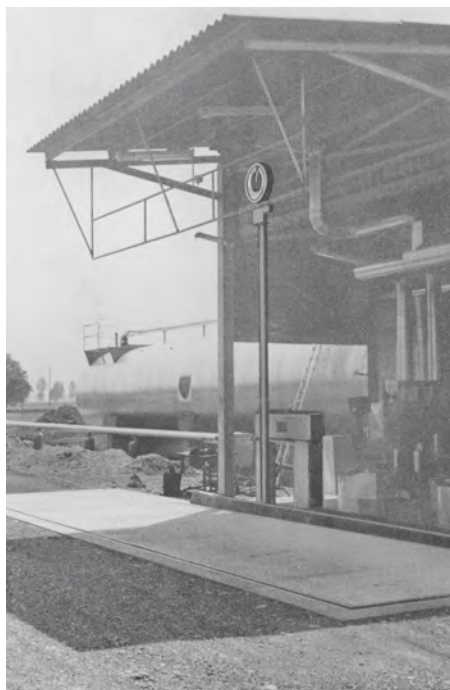
Waage in Tanklager mit Zweitanzeige
