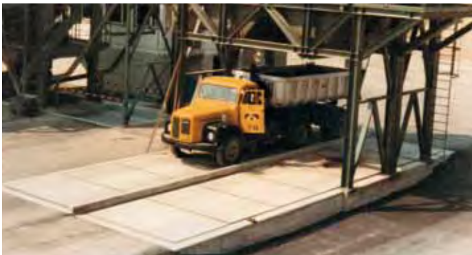
Doppel-Fahrzeugwaage unter einem Silo
